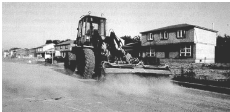
شکل ۱-۲ - احداث ساختمان های مسکونی
