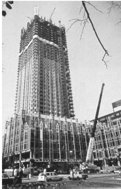
شکل ۱-۳ - عملیات ساختمانی یک مجتمع تجاری چند طبقه
